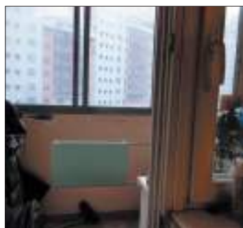
Перенос радиаторов отопления, подключенных к общедомовой системе, на лоджии, балконы и веранды.
