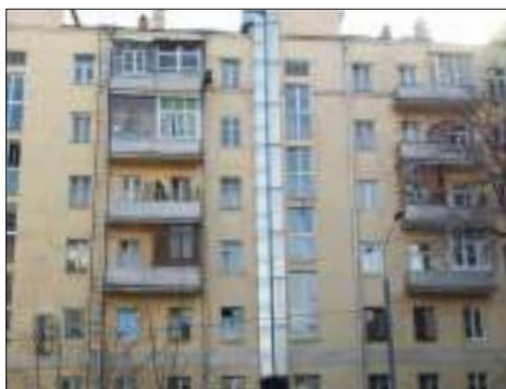
Устройство на фасаде многоквартирного дома вентиляционных коробов.
